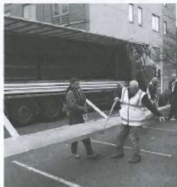
11. Dezember: Entladen an der Baustelle in London
