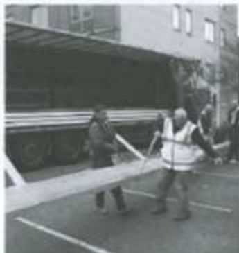
11. Dezember: Entladen an der Baustelle in London
