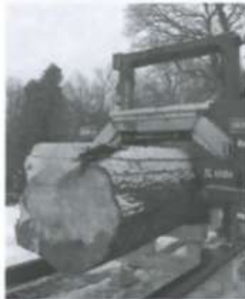
Januar 2010: Einschnitt des 12m langen Stammes vor Ort mit einer Spezielsägekonstruktion der Firmen Lässer und SERRA mit Stromversorgung durch einen THW-Generator
