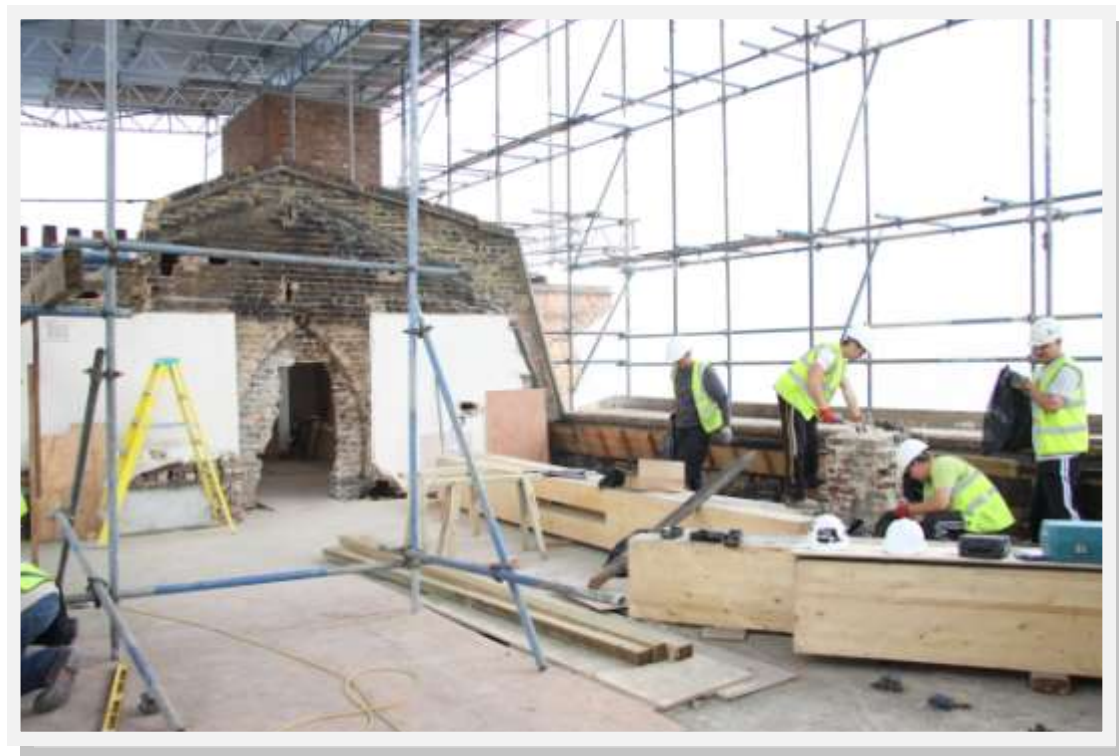
Ombyggnad av Plan 3, 663 och 661 Commerical Road
